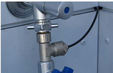
Die Wasserzuleitung wird direkt am Wasserhahn angeschlossen.
