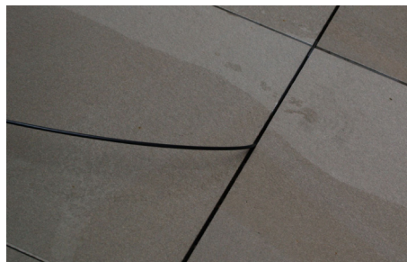
Die Wasserzuleitungen haben einen Durchmesser von vier Millimetern. Indem sie unter Holzrosten, im Splitt oder in Plattenfugen verlegt werden, können sie in der Regel unauffällig vom Wasseranschluss zu den Gefässen geführt werden.
