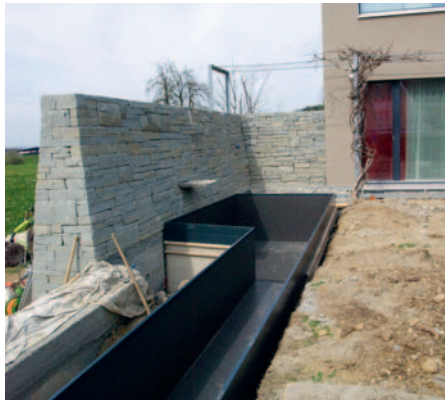
7. Eingepasstes Becken am endgültigen Standort
