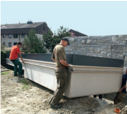
6. Einstellen in den vorbereiteten Baugrund
