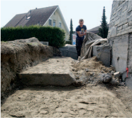
1. Vorbereitung des Untergrunds
