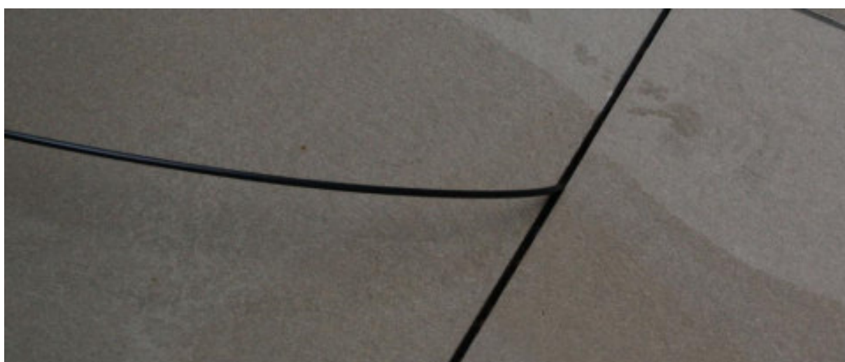
Bild 2: Zuleitung 4 mm in Plattenfuge verlegt.
