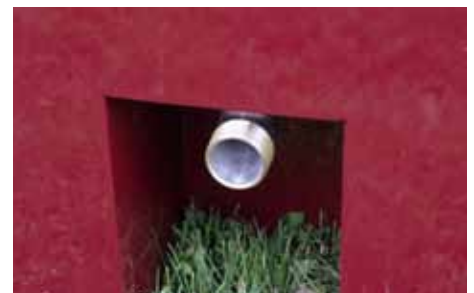
Wasserabführung aus Wasserbecken mit Zoll-Gewinde.
