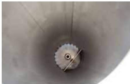
Blick von oben in den Multifunktionsschacht.
