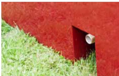
Kontrollierter Wasserablauf, integriert ins Becken
