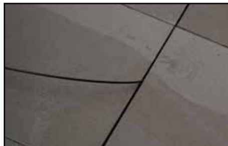
Die Wasserzuleitungen haben einen Durchmesser von vier Millimetern. Indem sie unter Holzrosten, im Splitt oder in Plattenfugen verlegt werden, können sie in der Regel unauffällig vom Wasseranschluss zu den Gefäßen geführt werden.
