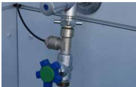
Anschluss 3/4" IG mit Abzweiger, Handrad und Raccord.
