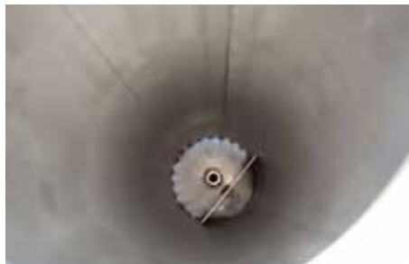
Blick von oben in den Multifunktionsschacht.
