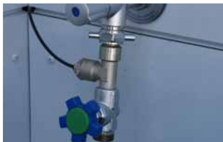
Anschluss 3/4" IG mit Abzweiger, Handrad und Raccord.
