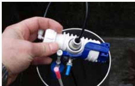
Der Bewässerungsautomat kann ohne Demontage einfach aus dem Schacht gehoben werden [z. B. zu Reinigungszwecken].
