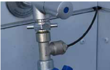
Die Wasserzuleitung wird direkt am Wasserhahn angeschlossen.
