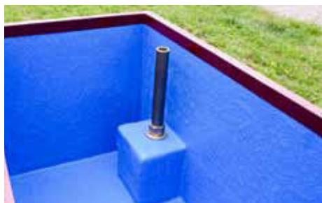
Integriertes Überlaufrohr
