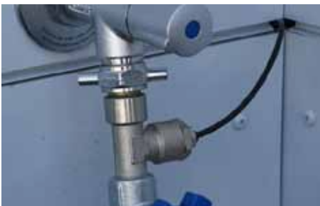
Die Wasserzuleitung wird direkt am Wasserhahn angeschlossen.
