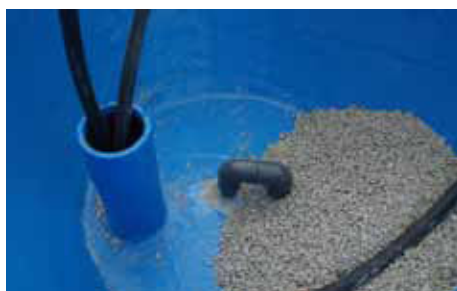
Gerades Rohr [breit] mit mehreren Kabeln.
