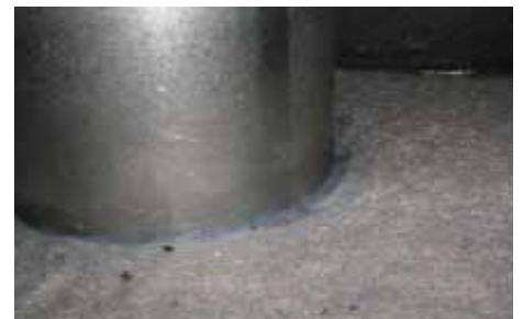
Auch um Schächte etc. ist der duroplant-Vegetationsträger dicht verschlossen, um eine Verschlammung des Wasserspeichers und die Gefahr einer Kapillarwirkung durch eingetragene Feinstoffe auszuschliessen.
